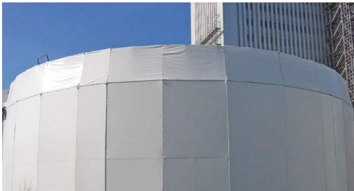
Comparées à des matériaux plus traditionnels, les solutions en matériaux composites souples offrent de nombreux avantages : modularité dans le temps, facilité de mise en œuvre, légèreté, coût.
