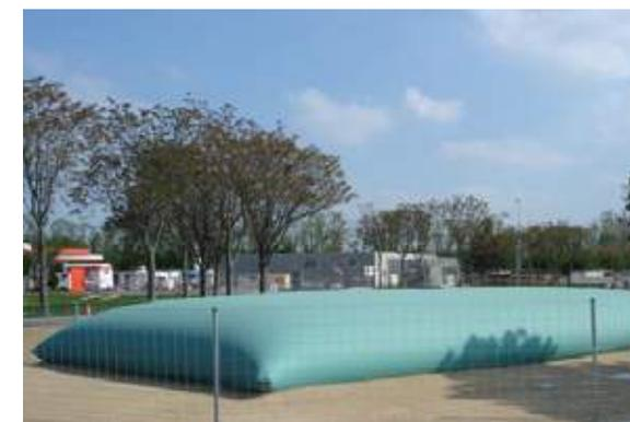
**RÉSERVE D'INCENDIE, BASSIN DE DÉCANTATION, BASSIN DE RÉTENTION SECONDAIRE** (stocker l'eau ou d'autres liquides temporairement ou durablement) **STRUCTURE DE STOCKAGE** (augmenter les possibilités de stockage)
