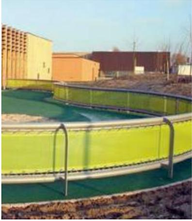
et ne demandant pas de nouvelle tension, 10 ans après un montage définitif), homogénéité maîtrisée du comportement au niveau des tensions bi-axiales et longévité esthétique renforcée comme longévité mécanique dûes principalement à une forte couche d'enduction protégeant la fibre Polyester. Cette innovation donne une nouvelle impulsion à l'architecture textile, et constitue également un apport décisif en matière de protection solaire. En effet, l'apparition du Soltis®, membrane
